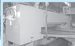
▲ レベラー装置の改良により生産工程の効率化をはかる
