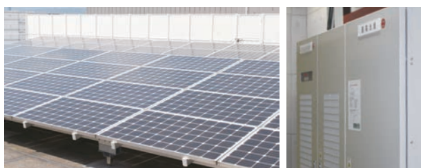
太陽光発電パネル(左)と蓄電池盤(右)
