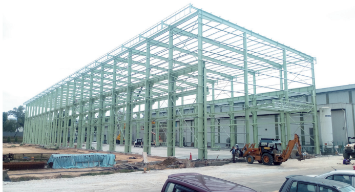
建設中のマレーシア工場
