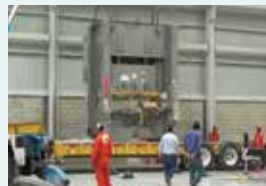
現地据付作業 移設後のアフターサービスも実施
