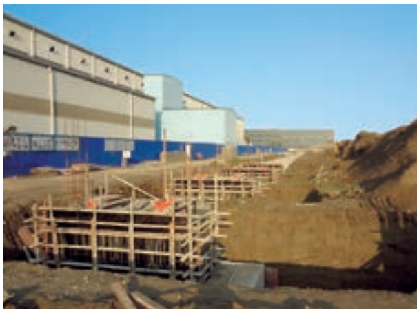
建設中の中国（南通）工場 11月中旬頃完成予定
