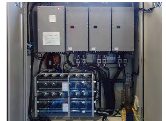
サーボ制御盤 (サーボアンプ・コンデンサー他)
