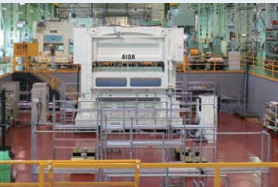
拡張した津久井第3工場第1棟組立エリア
