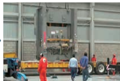
現地据付作業 この後、移設後のアフターサービスも行っている
