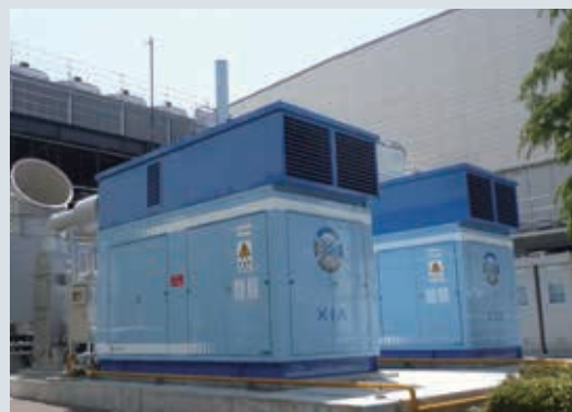
CGS施設外観
