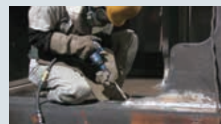
溶接継手部の疲労強度向上のためのハンマーピーニング処理
