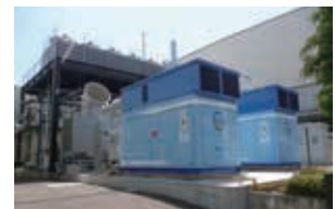
CGS設備外観
